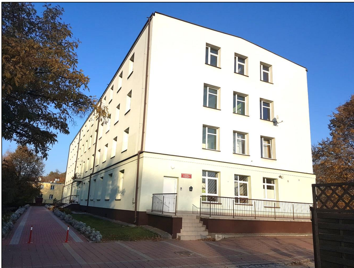
Widok elewacji budynku od strony południowo-zachodniej.
