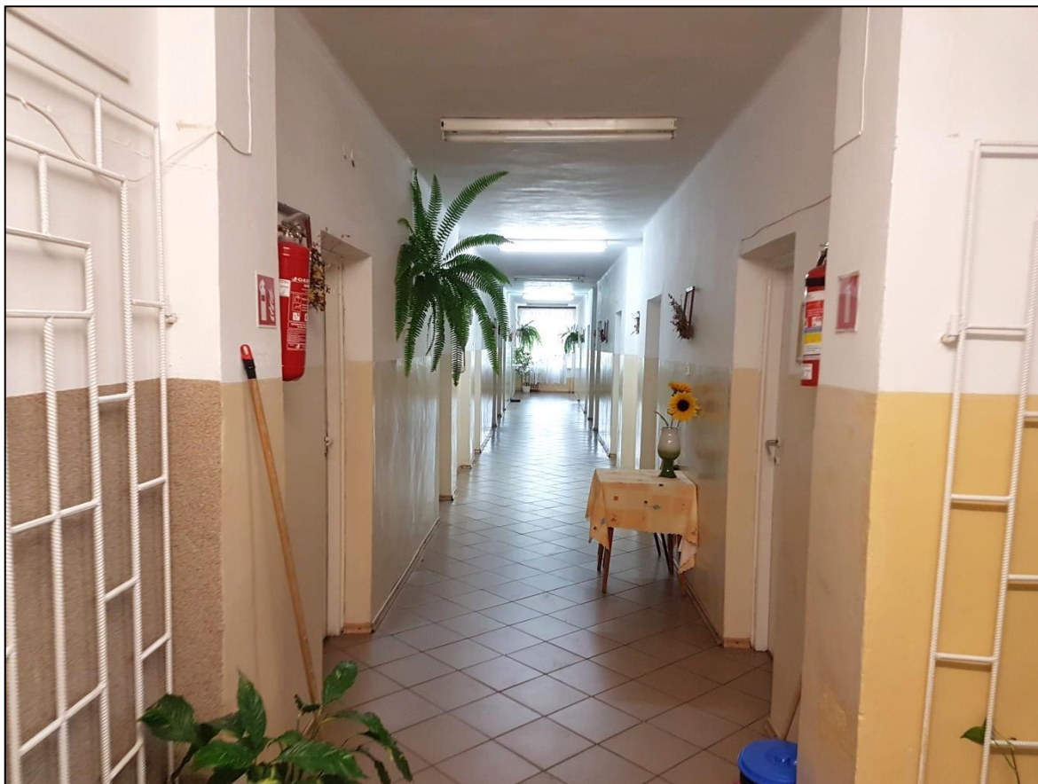
Widok korytarza na I piętrze w części północnej od strony klatki K1.
