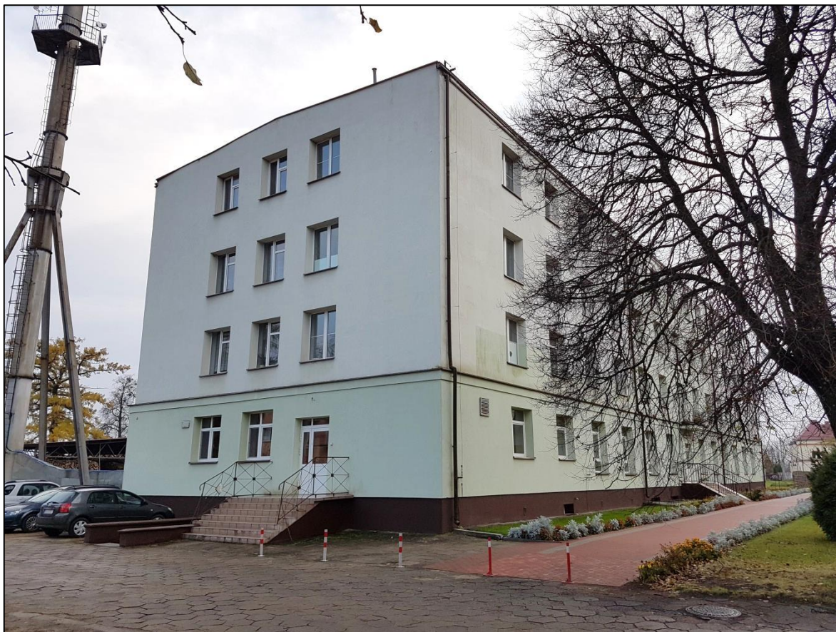
Widok elewacji budynku od strony północnej.
