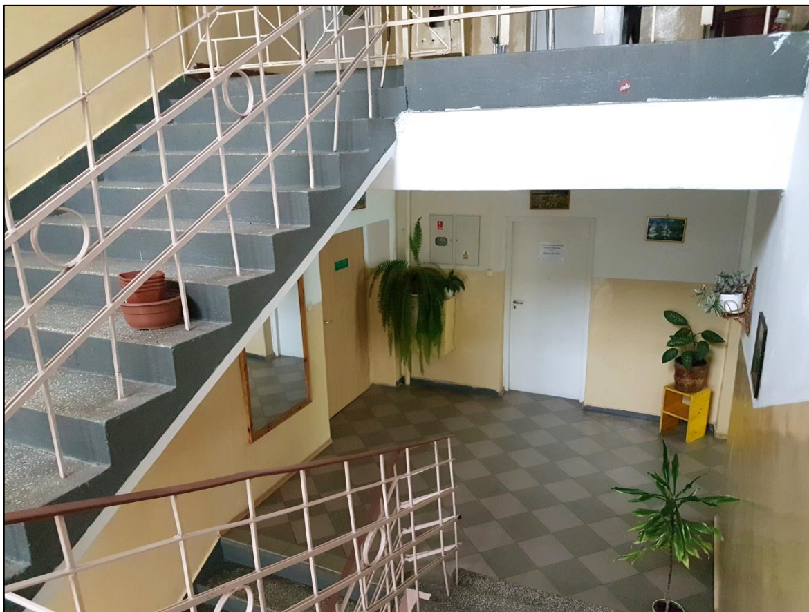
Widok spocznika na II piętrze w klatce K1.
