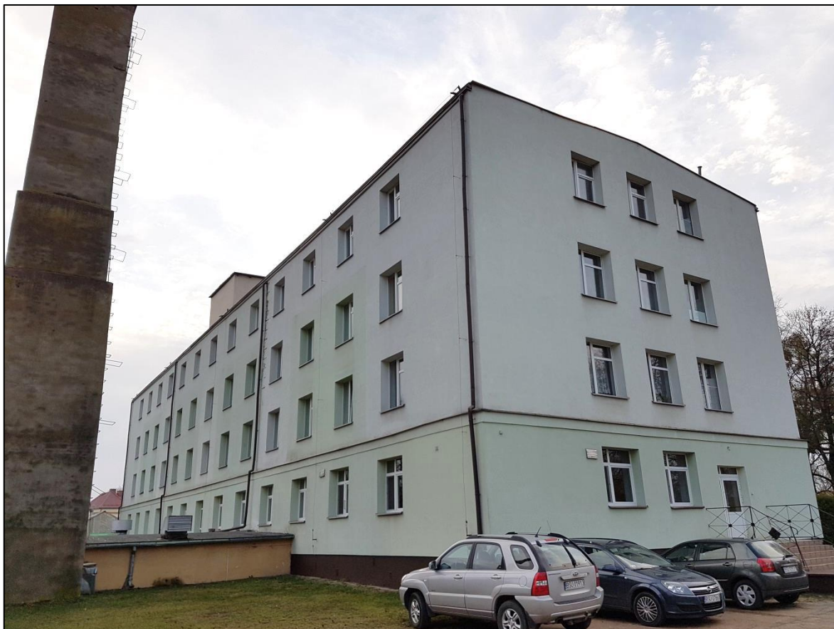
Widok budynku wraz z przylegającym budynkiem kotłowni od strony północno-wschodniej.
