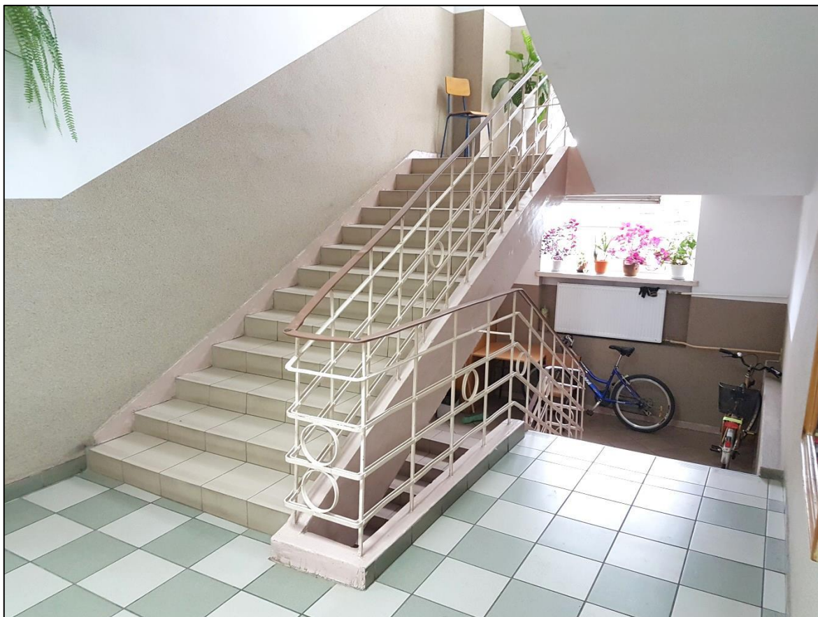
Widok zejścia w klatce K1 z parteru na spocznik półpiętra gdzie planowane jest nowe wyjście na zewnątrz.
