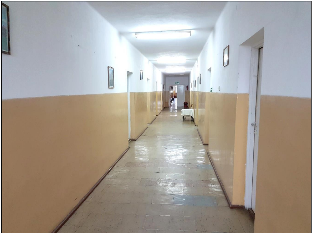
Widok korytarza na III piętrze pomiędzy klatkami K1 i K2.
