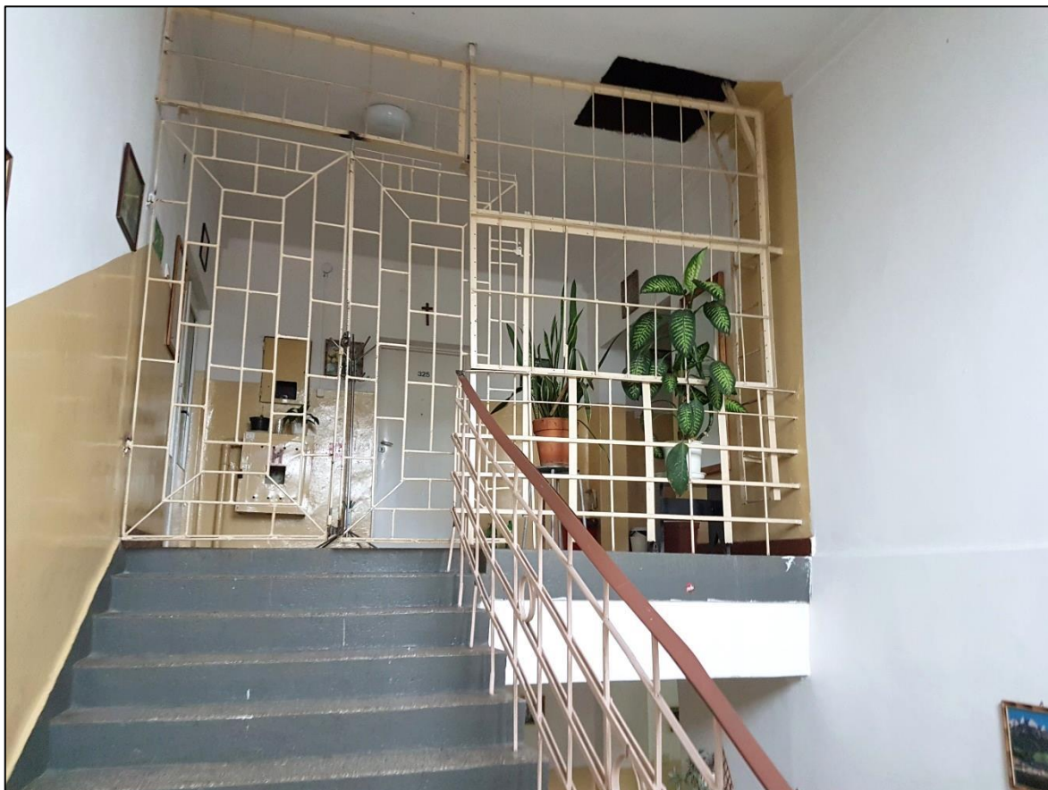
Widok spocznika na III piętrze w klatce K1.
