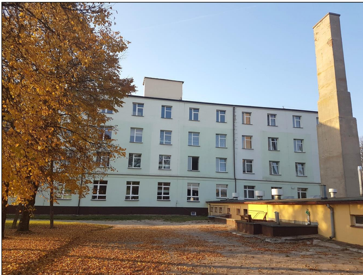
Widok elewacji budynku wraz z przylegającym budynkiem kotłowni od strony wschodniej.
