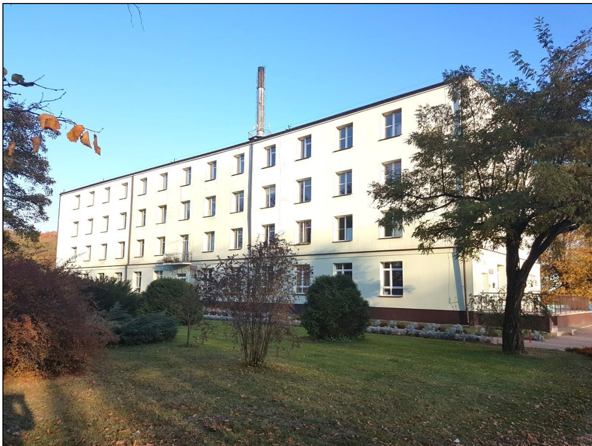
Widok elewacji budynku od strony zachodniej.
